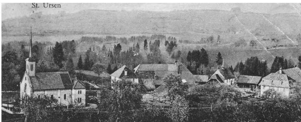
Südansicht des alten Dorfkerns mit der Kirche vor dem Umbau sowie der Kapelle vor 1933.
