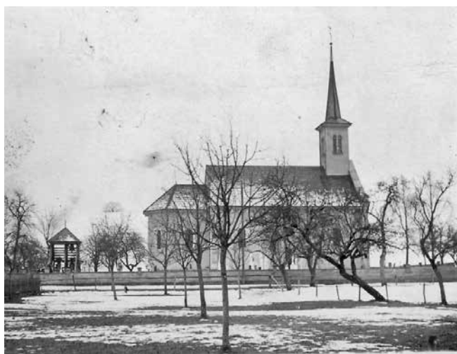
Nordansicht der Kirche mit Glockenstuhl vor dem Umbau von 1933.
